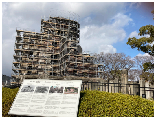
写真：世界遺産・原爆ドームは被爆後 5 回目となる保存工事中
